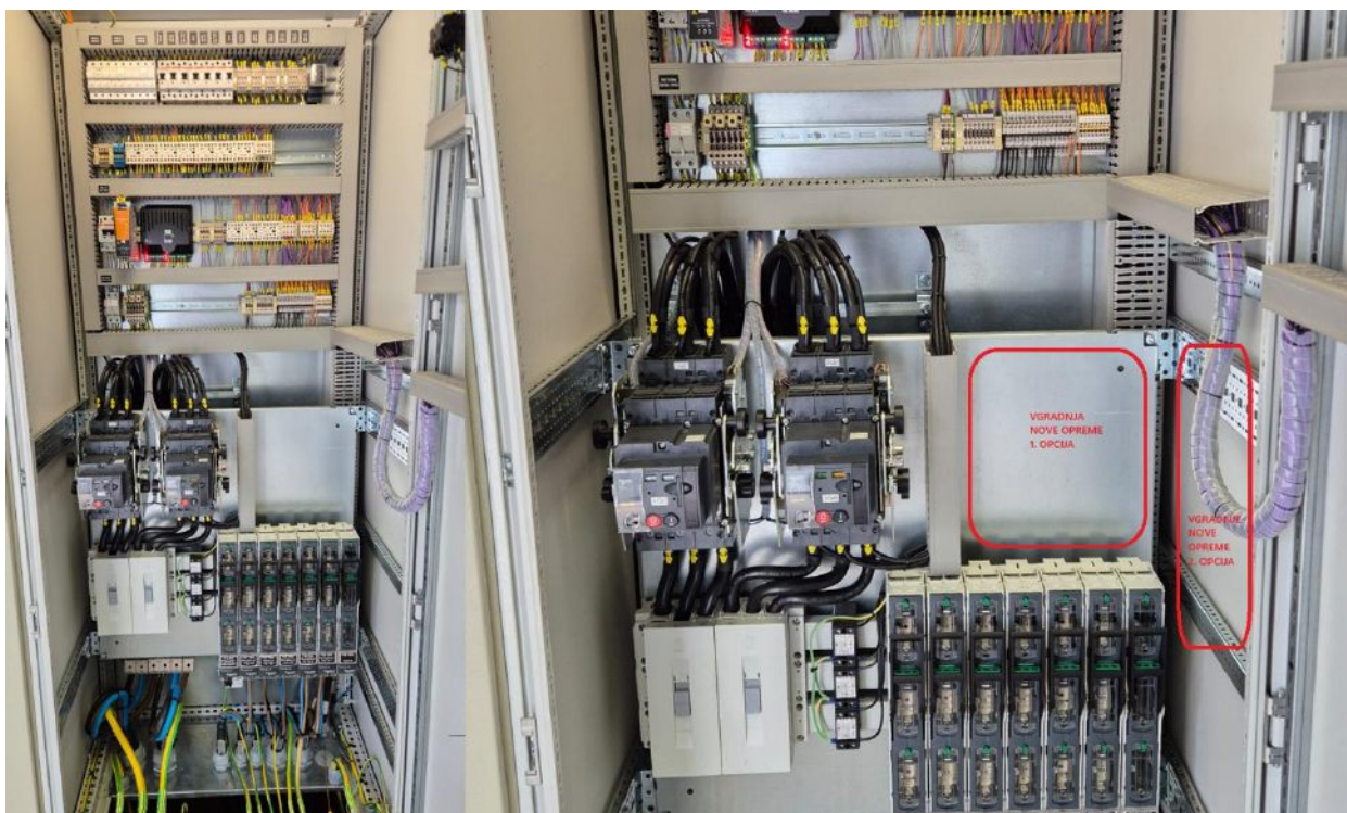
Slika 15: Izgled notranjosti obstoječega razdelilnika lastne rabe =AK+N/AC z označenima dvema opcijama vgradnje nove opreme
