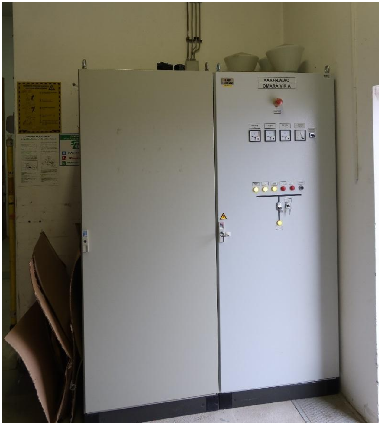
Slika 13: Omare vira A, omare se demontira vključno s kablovjem in odpelje na začasno skladiščenje
