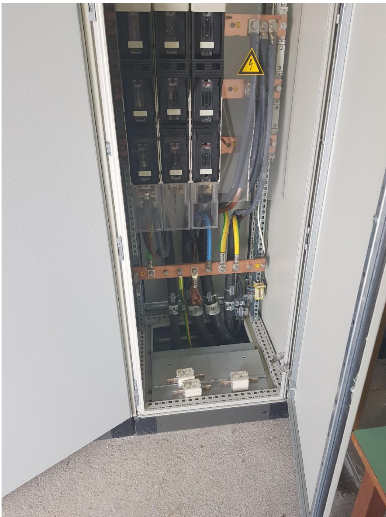
Slika 12: Omara =AK+N.S2/AC, pogled znotraj (priklučitev energetskih kablov) - detajl
