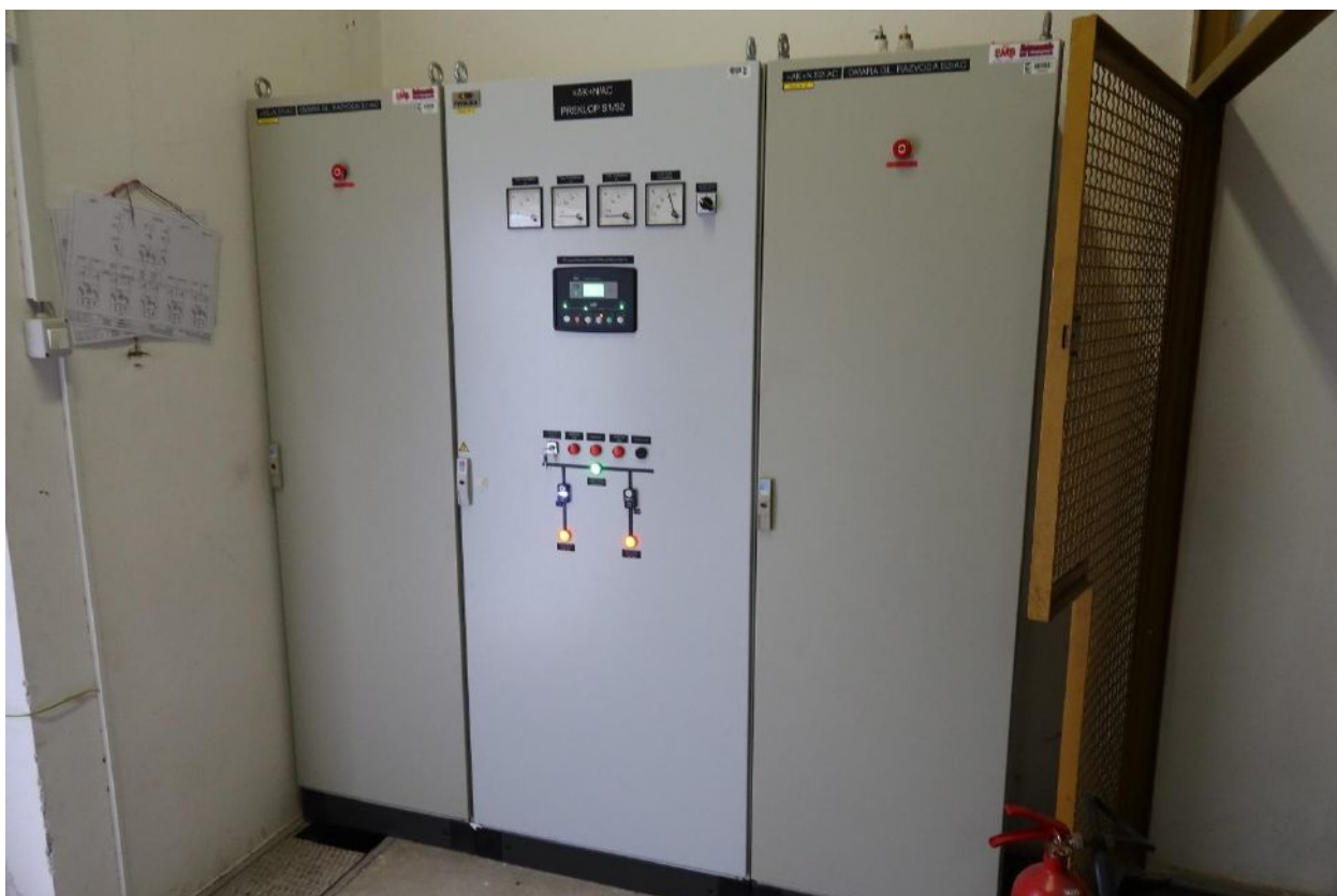
Slika 7: Omare preklopnega polja izmenične lastne rabe, ki se prestavijo na začasno lokacijo zaradi ureditve prostora 20 kV stikališča
