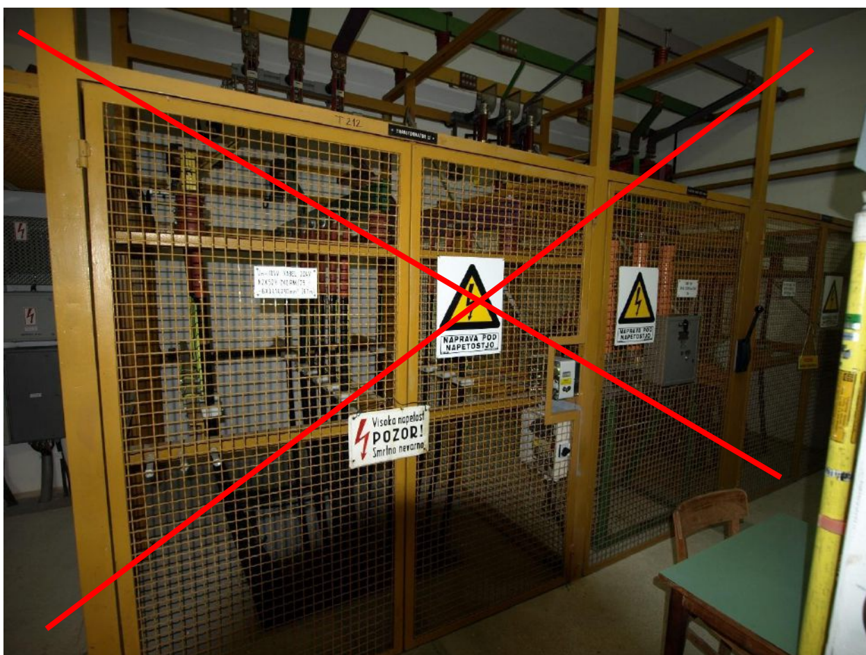
Slika 1: 10 kV celice v prostoru terciarja 10 kV, celice se v celoti odstranijo (slika 1)
