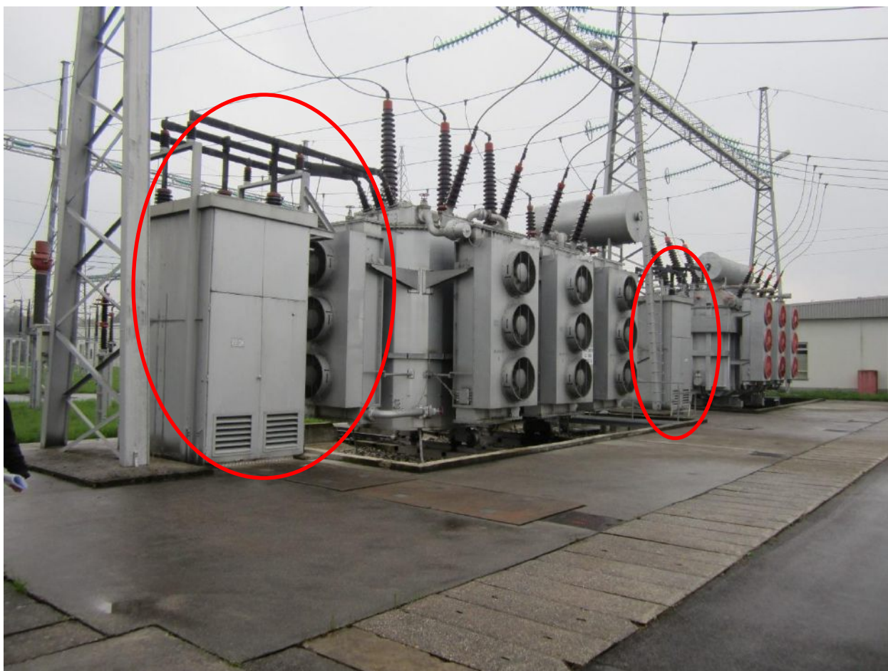
Slika 3: 10 kV povezave ob energetskih transformatorjih T211 in T212, povezave se v celoti odstranijo
