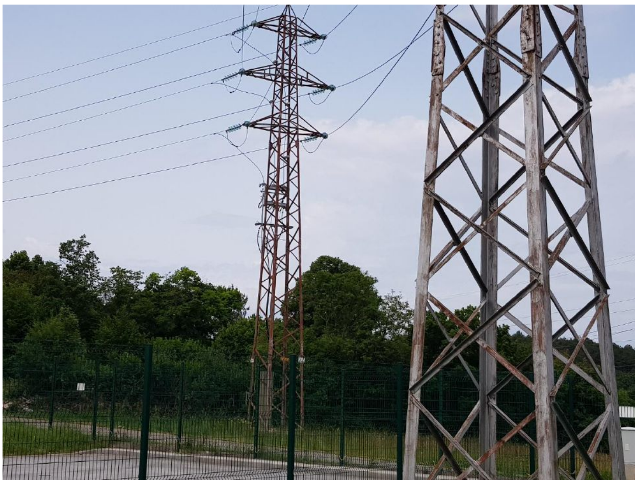
Slika 14: Obstoječi DV steber SM2, 20 kV ločilnik in ostala 20 kV oprema, ki se demontira in ponovno namesti na novem DV stebru SM1
