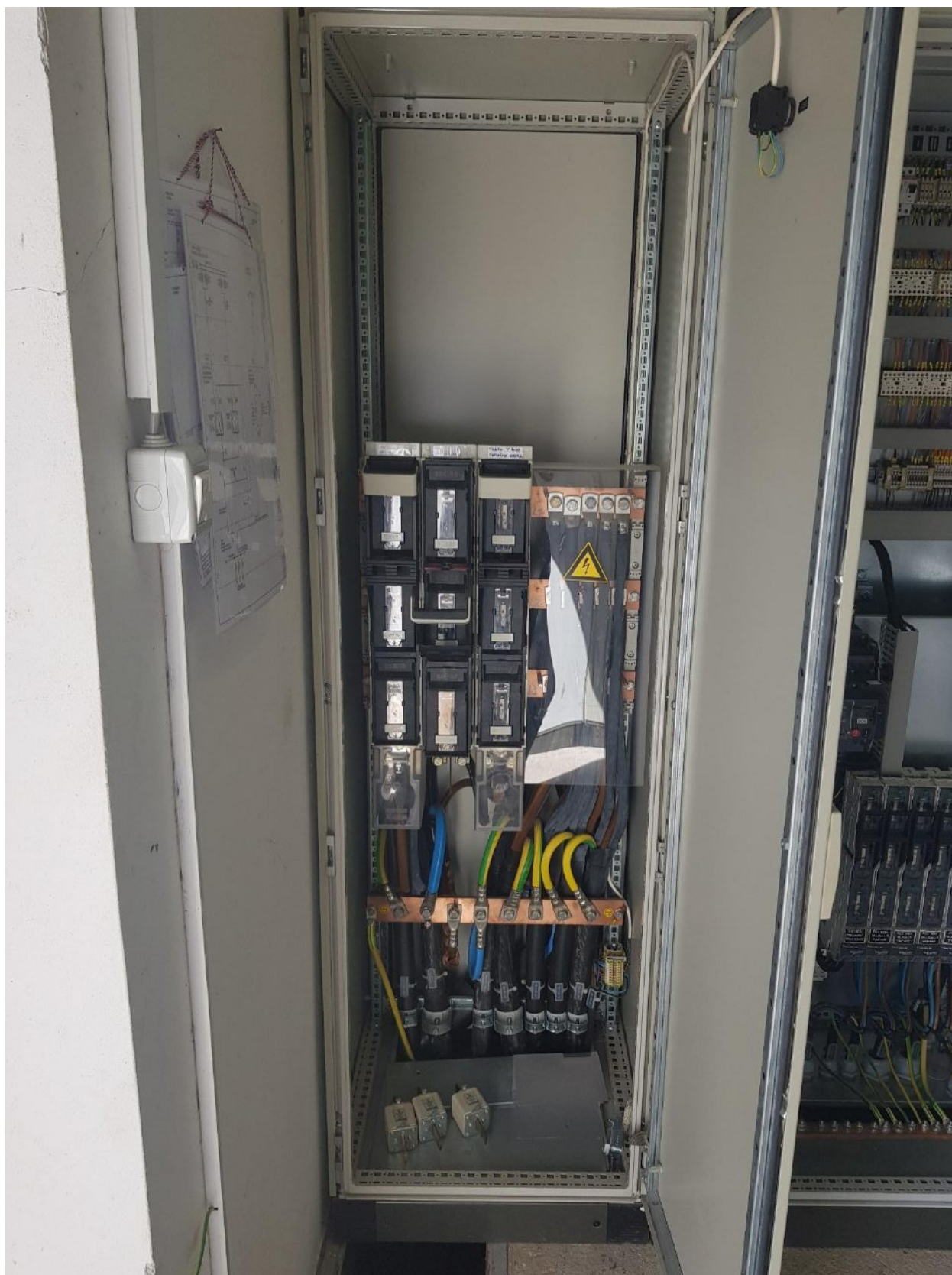
Slika 8: Omara =AK+N.S1/AC, pogled znotraj (priključitev energetskih kablov)
