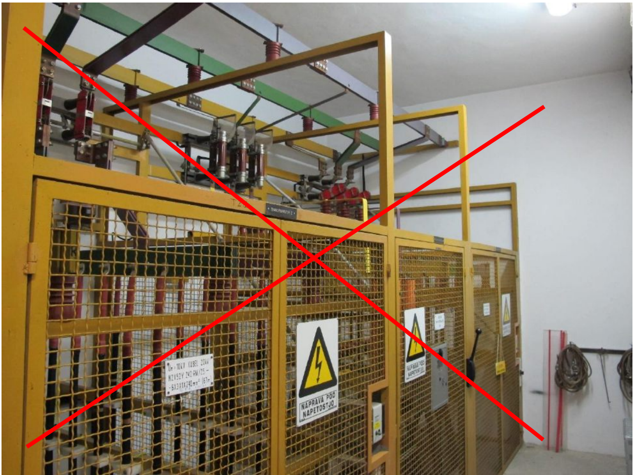
Slika 2: 10 kV celice v prostoru terciarja 10 kV, celice se v celoti odstranijo (slika 2)
