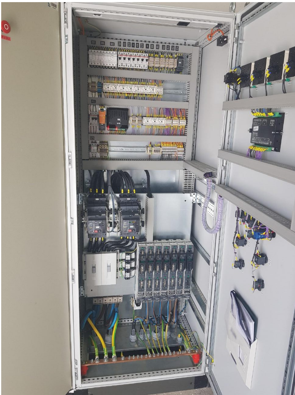
Slika 10: Omara =AK+N/AC, pogled znotraj (priklučitev energetskih kablov)
