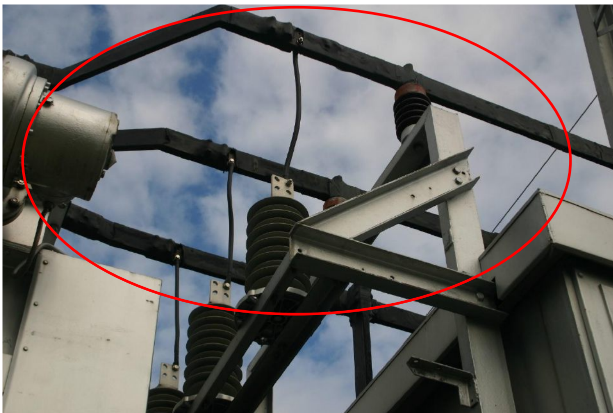
Slika 5: Povezave na terciar transformatorja T212, povezave se odstranijo
