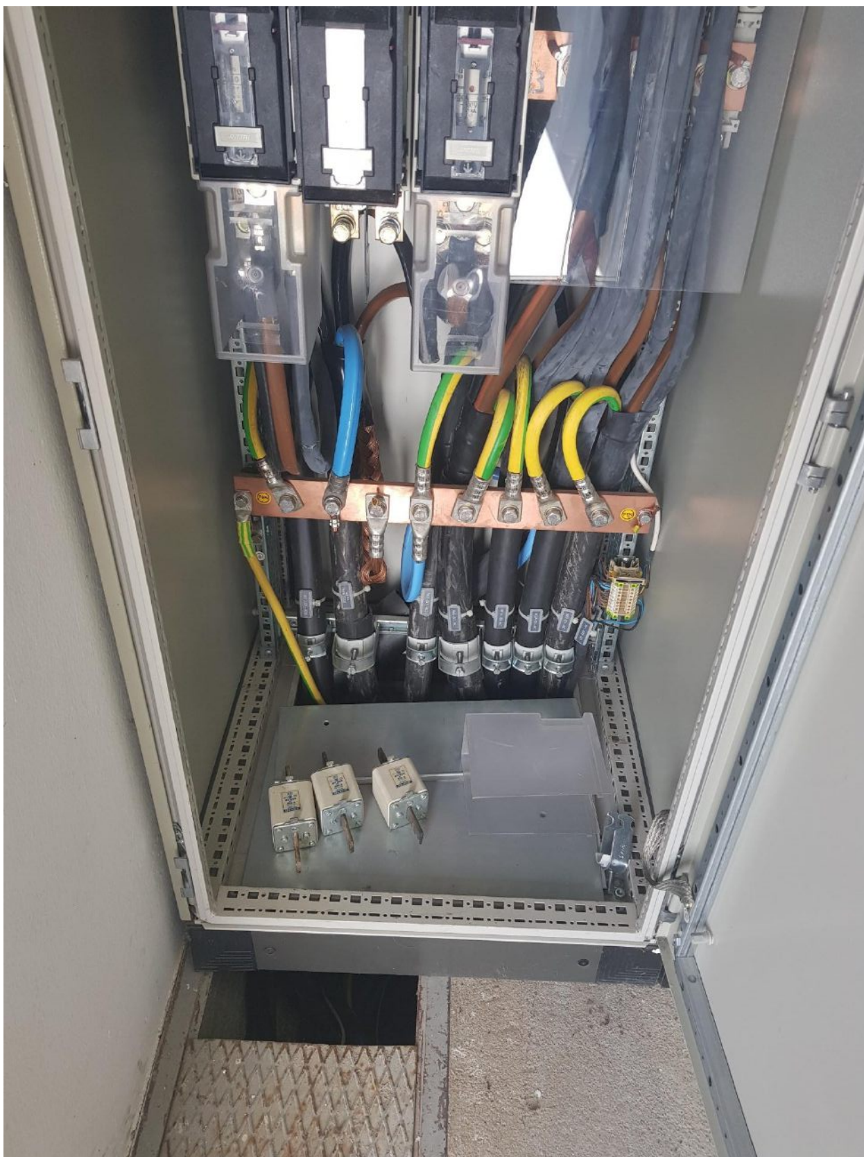
Slika 9: Omara =AK+N.S1/AC, pogled znotraj (priključitev energetskih kablov) - detajl
